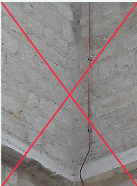
Alors que les instructions ont été préalablement données afin que les fixations du conducteur se fassent dans les joints de la maçonnerie, toutes les fixations ont été placées dans les pierres ! Il aurait suffi d'utiliser des systèmes de fixation mieux adaptés à la situation existante permettant d'aller chercher une maçonnerie plus cohérente en profondeur, en général, quelques centimètres complémentaires suffisent © SPW/AWaP
